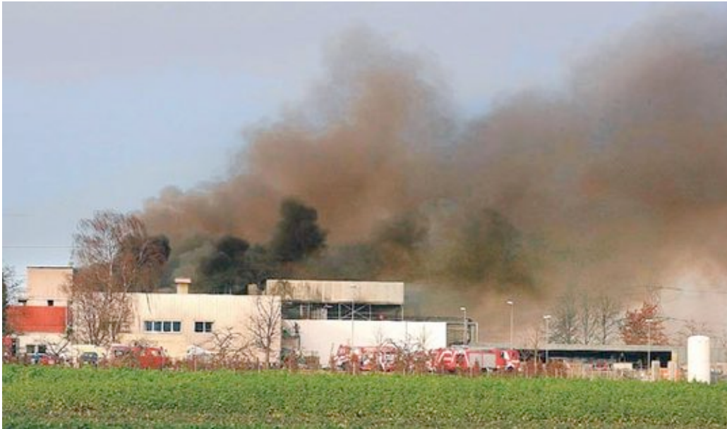
Abbildung 13: Großbrand im Fertigungswerk Rommelsbach (Foto: Haas)
